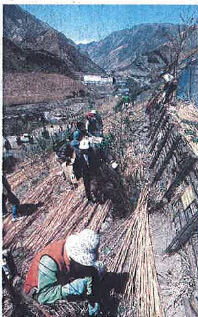
市民ボランティアが荒廃した足尾の山に緑の再生を始めて6年目。渡良瀬遊水地で育ったヨシが今年初めて使われた。4月22日、栃木県足尾町の大畑沢緑の砂防ゾーンで
