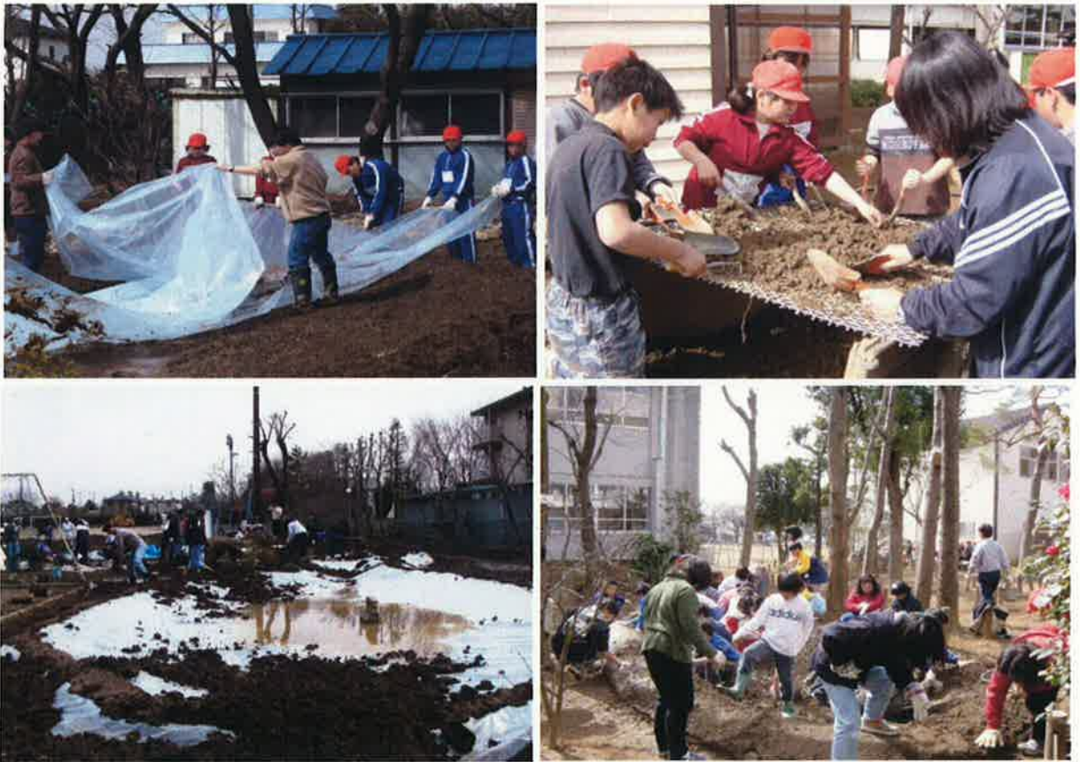
図2. ビオトープ池の造成の様子. 池の原型の上にビニールシートを敷き(左上), 根や石を取り除いた土(右上)をその上にまき広げたのち(左下), 押し固めていく(右下).
