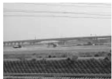
伊勢湾岸自動車道盛り土現場
