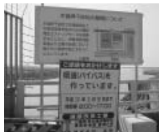
木曾岬県道バイパス工事
